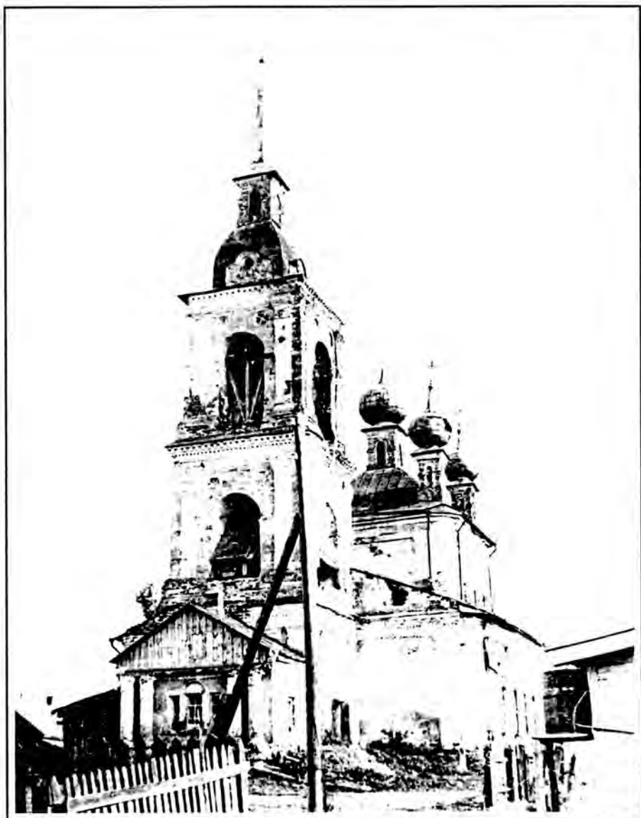
Кады. Никольская церковь Фото П.Дубровина. 1968 г.
